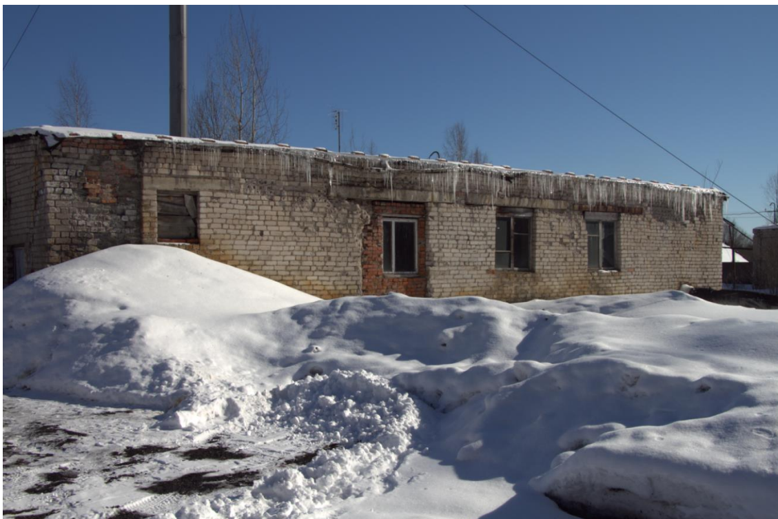
Внешний вид котельной
